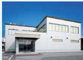
●松戸支店・工場
